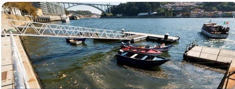
Intercetor marginal com sinais evidentes de mau estado
